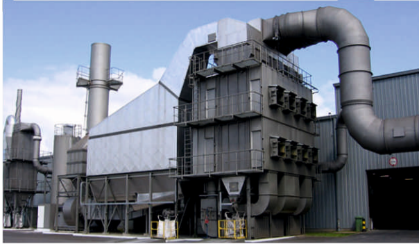
Jetpulse Filtre Ünitesi - Döküm Fabrikası
